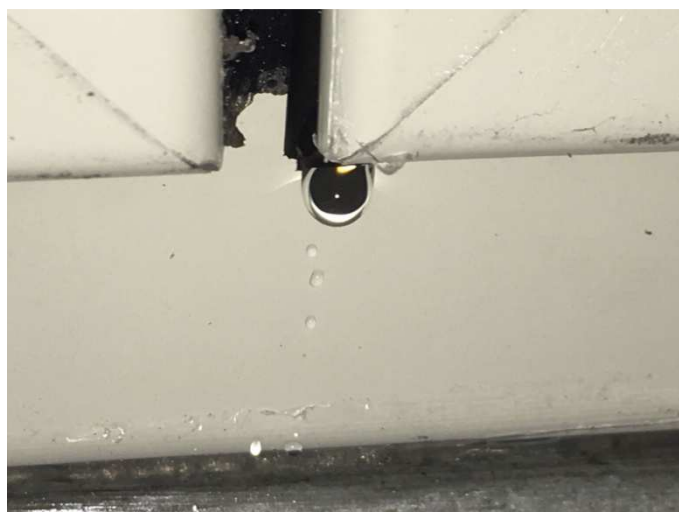
Foto 2. Campione sottoposto a prova durante i test di tenuta all'acqua
